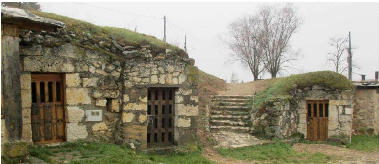
*Bodegas con cubierta de perfil alomado y acabado con cubierta vegetal tradicional.
